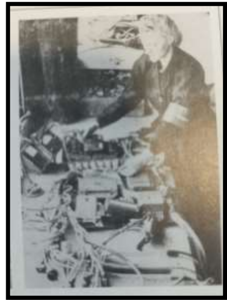
Abb. 35: Eine WNF-Arbeiterin bei der Überprüfung von Schaltkästen
