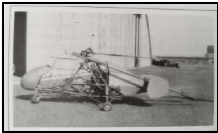
Abb. 40: Der Prototyp eines Strahlhubschraubers, „WNF342V1“
