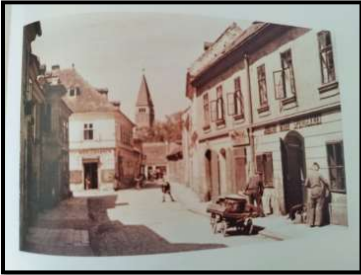
Abb. 19: Blick in die „Lange Gasse“. Von besonderem Interesse: Im Vordergrund ist ein Handkarren zum Transport von Waren zu sehen, fotografiert zwischen 1939 und 1942
